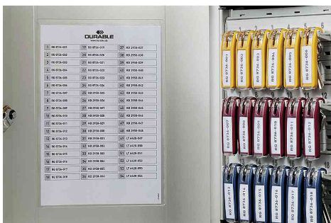
Armoire à clés KEY BOX - vue de l'intérieur
